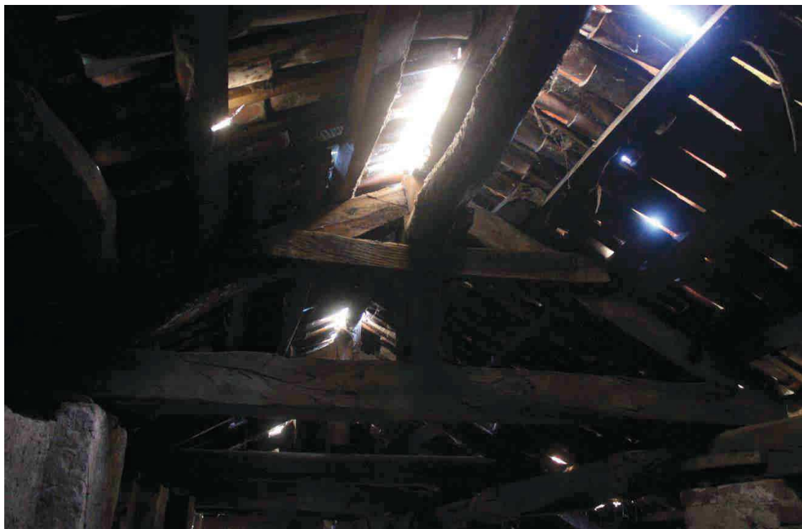
Figura 7 - Vista interna del tetto della "Manica dei Ricostruttori" - L'evidente degrado del tetto è la causa delle copiose infiltrazioni di acqua piovana
