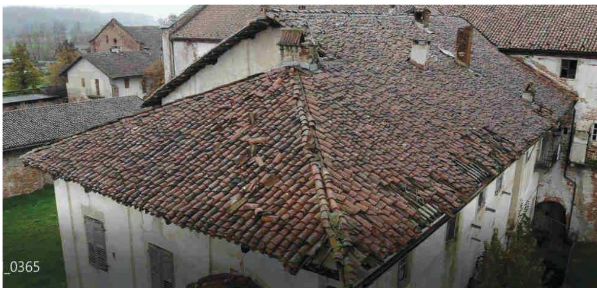
Figura 6 - Vista della "Manica dei Ricostruttori" - Evidente degrado del manto di copertura
